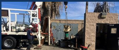
El distrito está rehabilitando el Pozo No. 2 para mejorar su eficiencia general y garantizar un suministro de agua sostenible y seguro. Para hacer esto, el proyecto comienza con inspecciones y limpieza de cualquier sedimento que se ha acumulado a lo largo del tiempo. El sistema de bomba y motor se evalúa para reemplazo o reparación junto con actualizaciones de tuberías y sistemas eléctricos.
